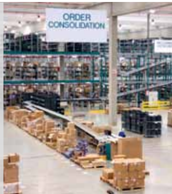
Scaffalatura multipiano con passerelle Multi-tier shelving with walkway decking
